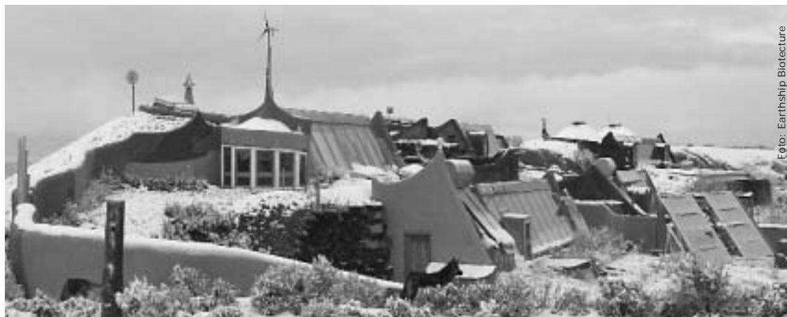
Gut gedämmt mit Müll und Naturmaterialien!
